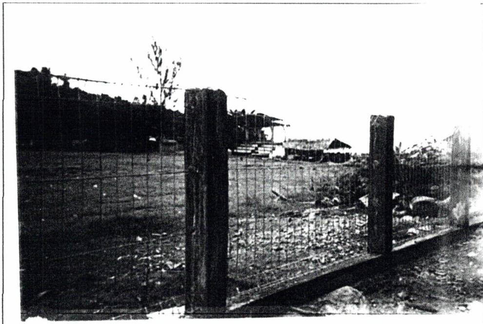
Gambar 1. Pagar Gedung Sarang Burung Walet Air Bangis Sudah Dipasang 100%
