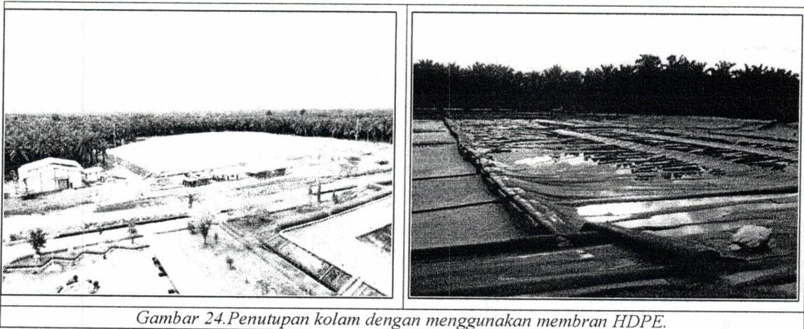
Gambar 24. Penutupan kolam dengan menggunakan membran *HDPE*.
