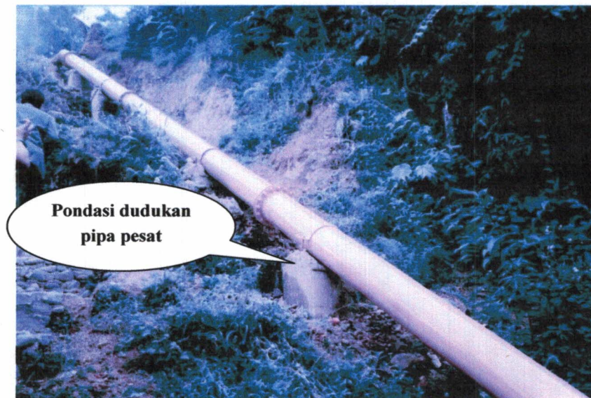
Gambar 2.6 Pondasi dudukan pipa pesat
