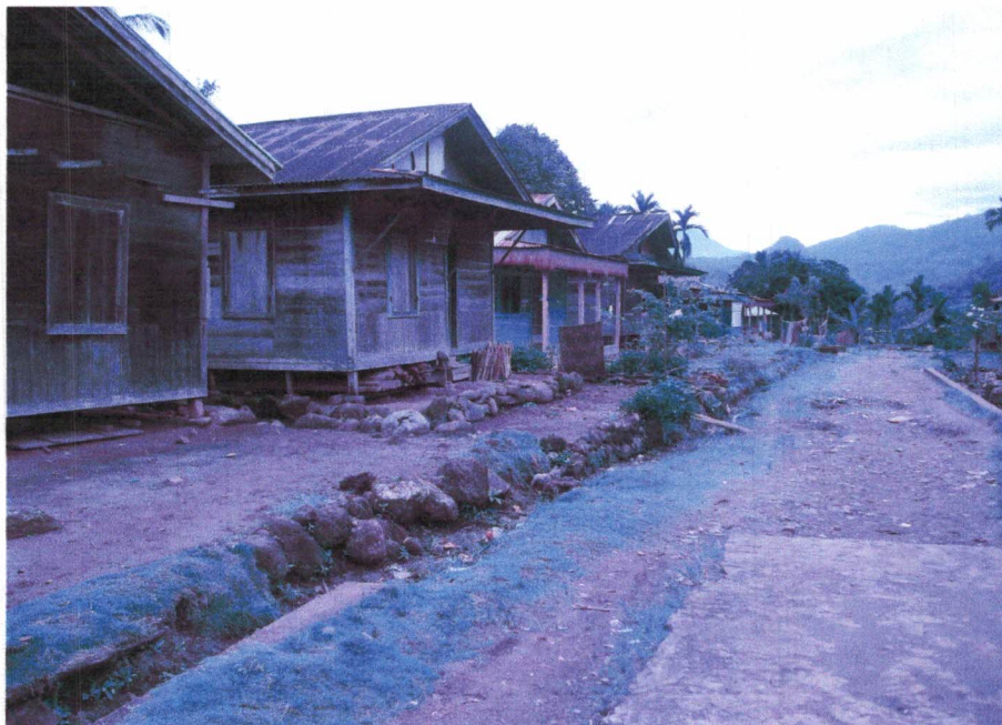
Gambar 8. Rumah Penduduk yang akan dialiri listrik PLTMH Tombang
