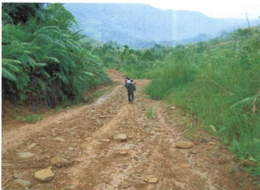
Gambar 2. Akses Jalan ke Kampung Tombang Mudik
