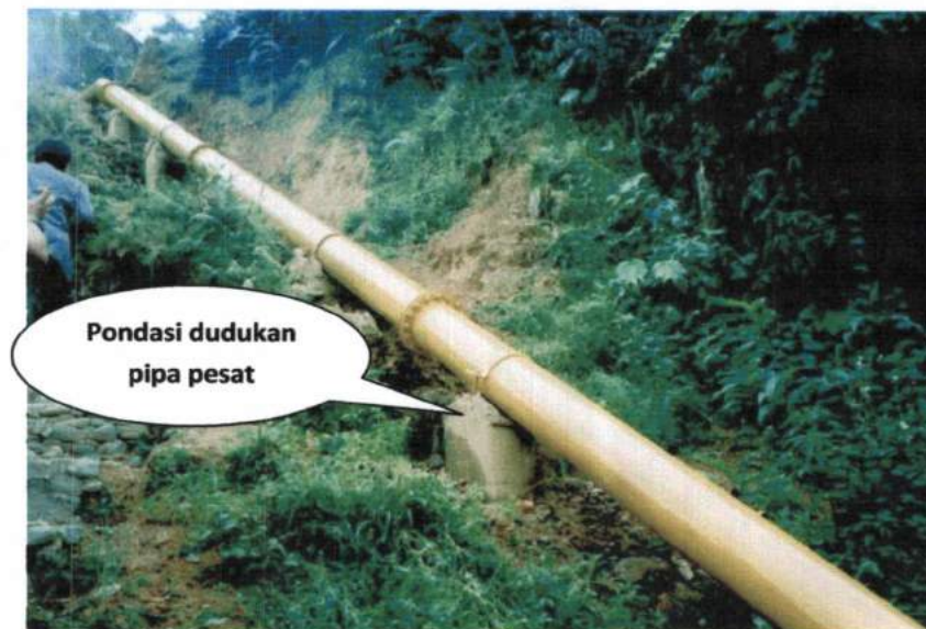
Gambar 2.6 Pondasi dudukan pipa pesat
