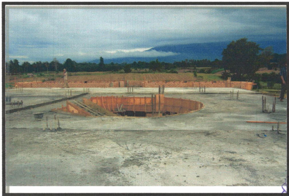
PENGECORAN PLAT
