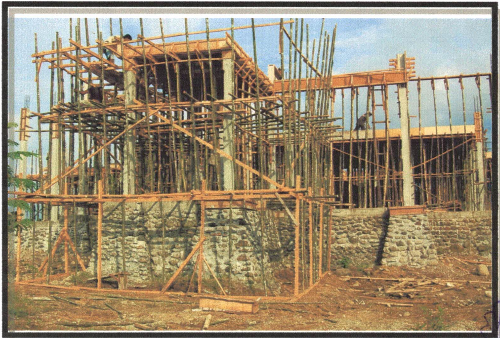
PEMASANGAN BEKISTING BALOK
