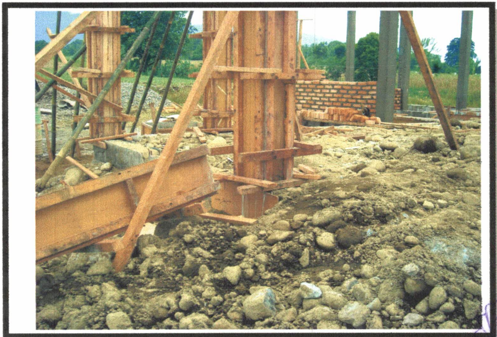
PEMBONGKARAN BEKISTING KOLOM
