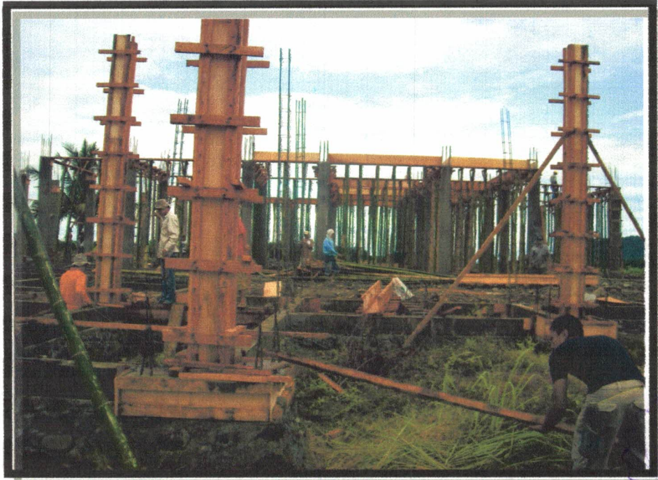
PENGECORAN KOLOM
