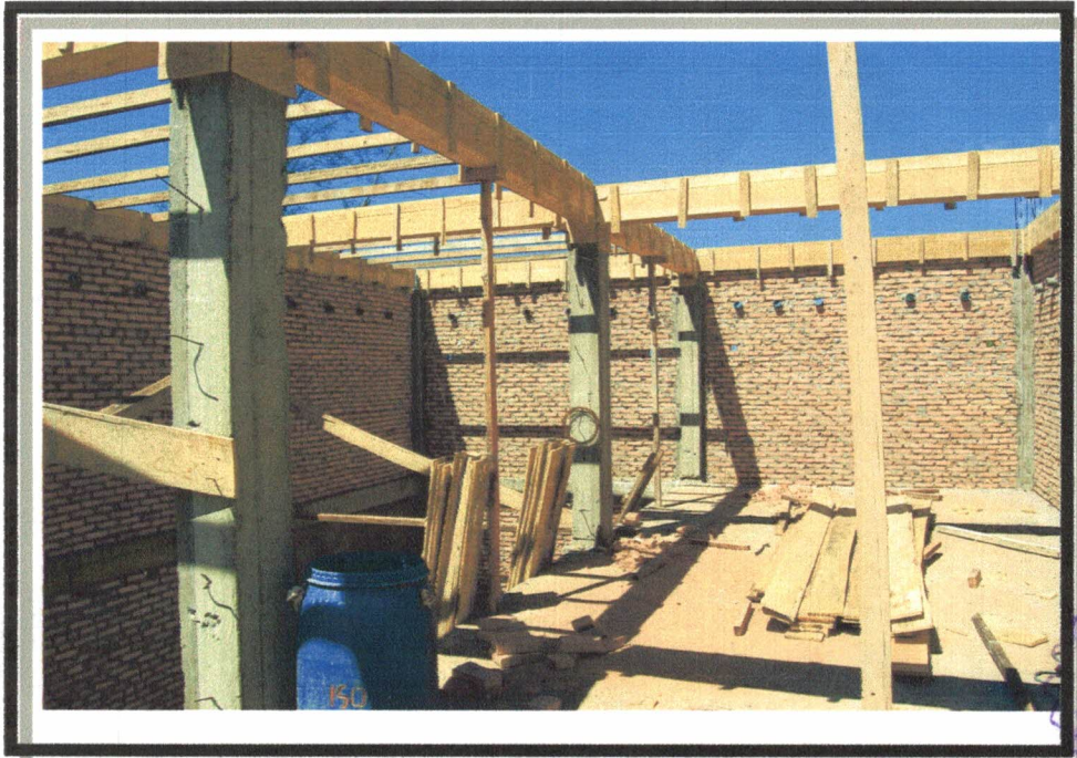
PEMASANGAN BEKISTING BALOK
